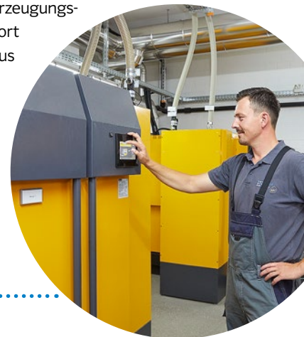
Die Pellet-Kessel erzeugen fossilfreie Nahwärme.
